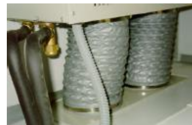
Рис. б) – Воздуховоды фрикулинга
