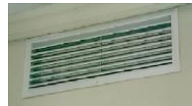
Рис. с) – Внешняя контролируемая защитная решетка с префильтром
